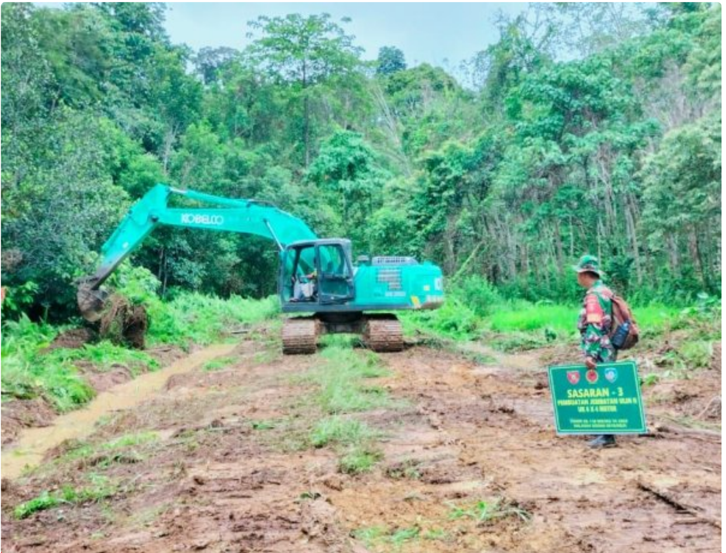
Progres sasaran fisik pembukaan badan Jalan TMMMD ke-118 Capai 31 Persen
