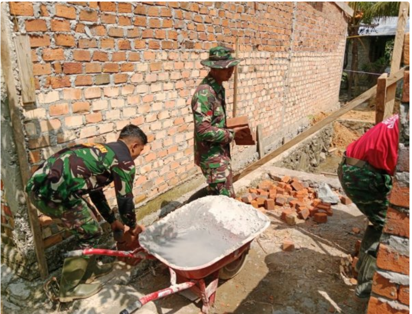
Satgas TMMMD Ke- 118 Wiltas Kodim 0910/Malinau Terus Kebut Pembangunan MCK Gereja
